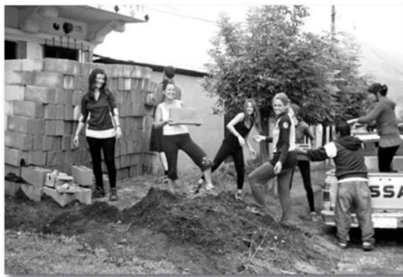
Un grupo de voluntarios y voluntarias colaborando en la construcción de una vivienda. Foto: Cooperatour
